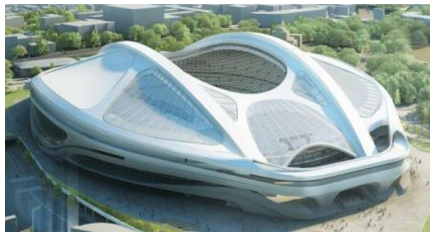
図 1 公開された国立競技場
